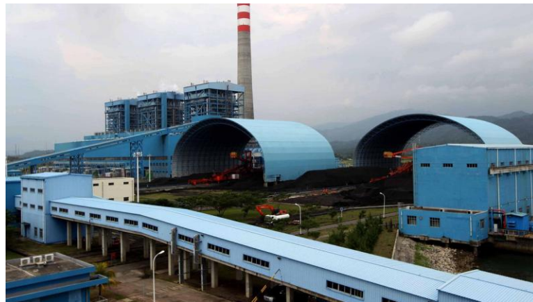
Gambar 2. 2 Pembangkit Listrik Tenaga Uap
