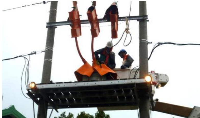
Gambar 2.2 Pemeliharaan jumper transformator
