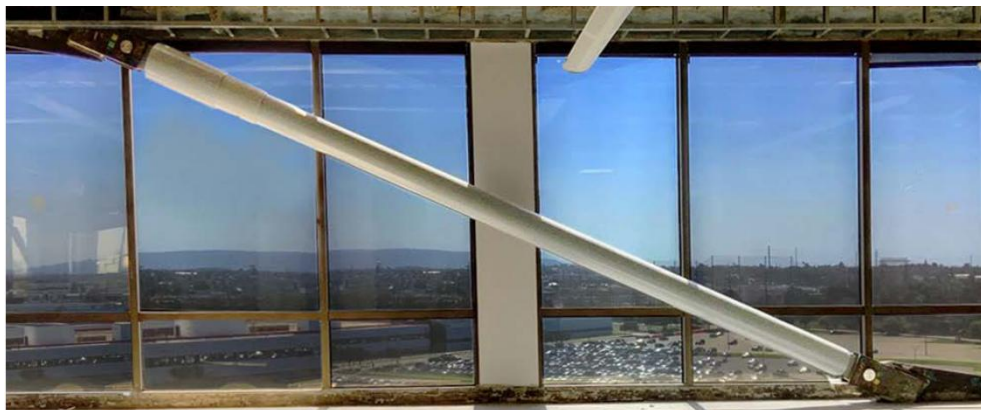
Gambar 2.22 Contoh FVD dengan Pola Pemasangan Diagonal
