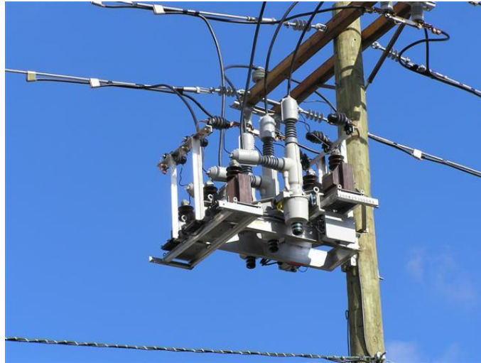
Gambar 2.10 Contoh Peralatan Hubung ( Switching ) pada Sistem Distribusi (Sumber : (PT. PLN - Persero 2010))
