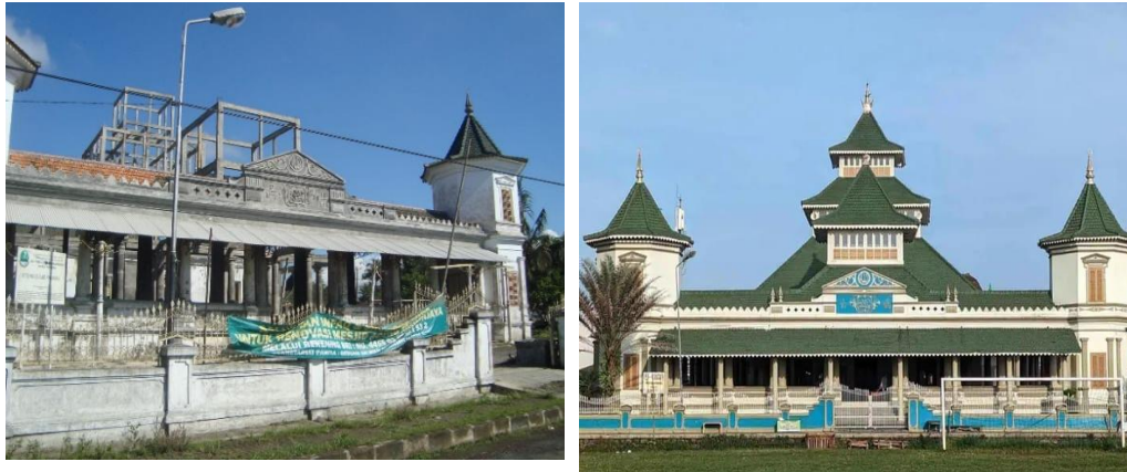
Gambar. 3.18 Renovasi setelah gempa bumi tahun 2010 dan kondisi setelah renovasi.
