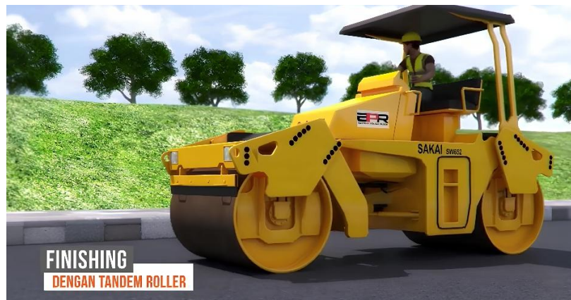
Gambar 2.7 Pekerjaan Finishing dengan Tandem Roller
