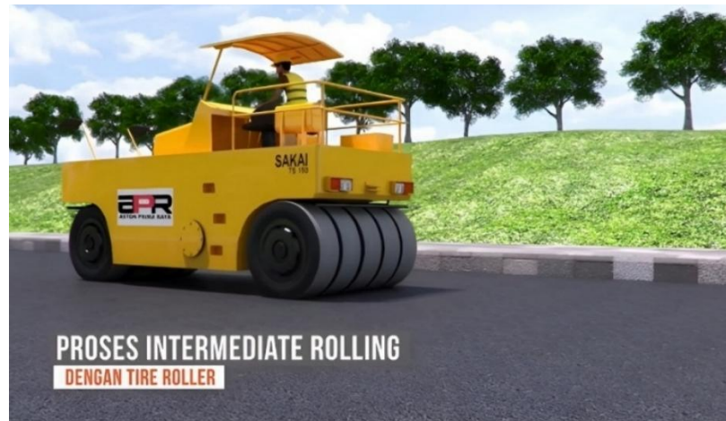
Gambar 2.6 Pekerjaan Finishing dengan Tire Roller
