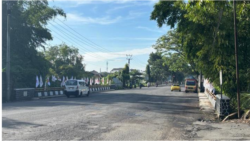
Gambar 3.2 Kondisi Jembatan Ciloseh
