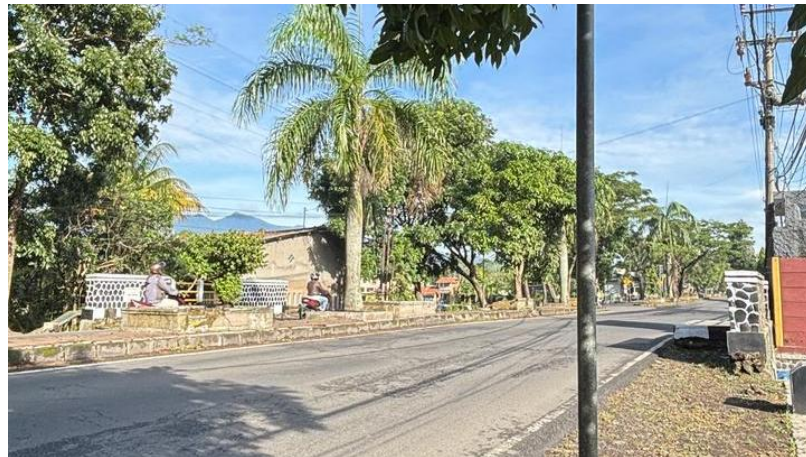
Gambar 3.3 Kondisi Jembatan Cibengkok
