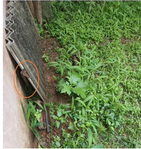
Kondisi septic tank yang di kubur dibawah tanah di balik papan tersebut terdapat paralon untuk menyedot lumpur hasil pengendapan
