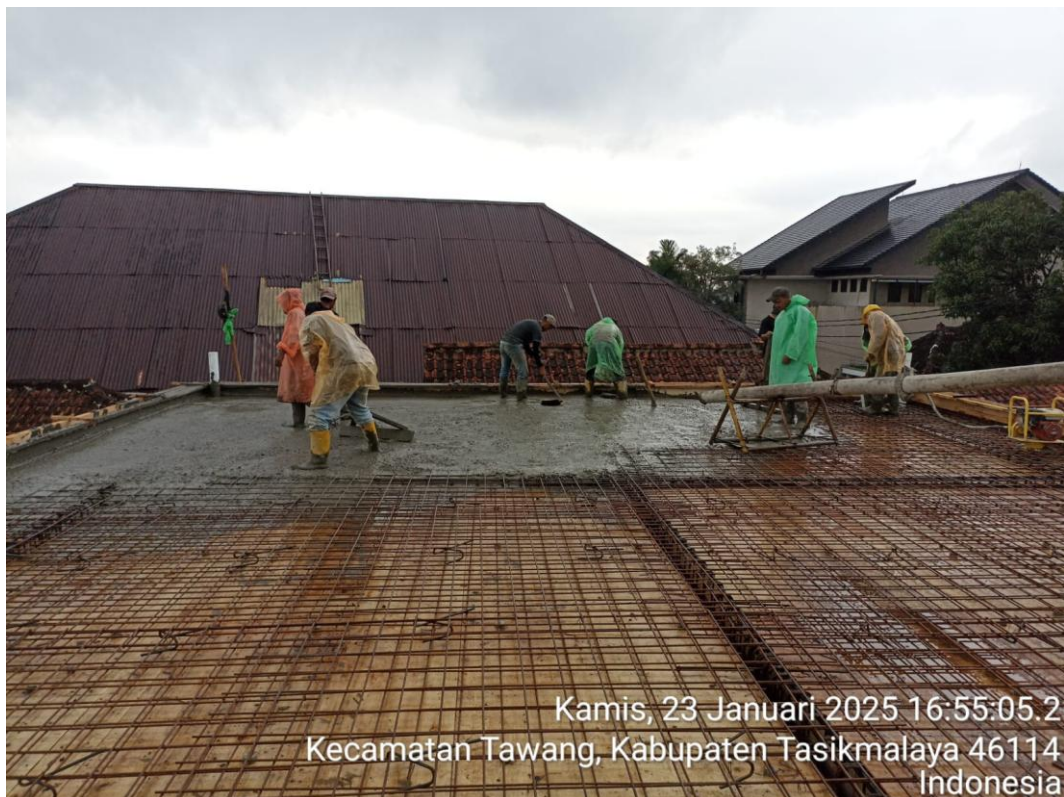
Gambar 3.22 Bekisting Pelat Lantai
