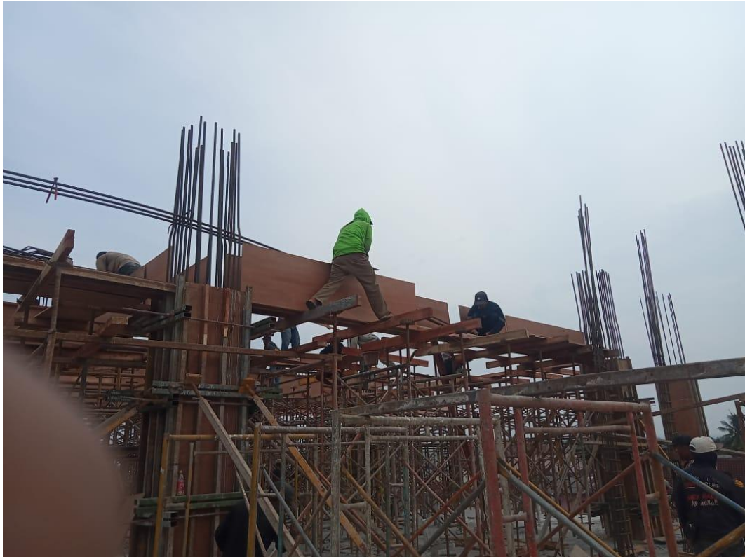
Gambar 3.23 Bekisting Kolom
