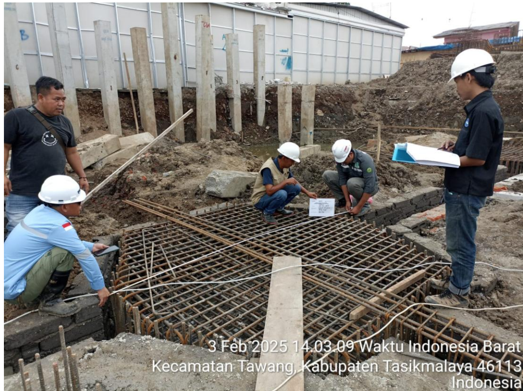
Gambar 3.19 Bekisting Batako Pile Cap dan Balok Basement
