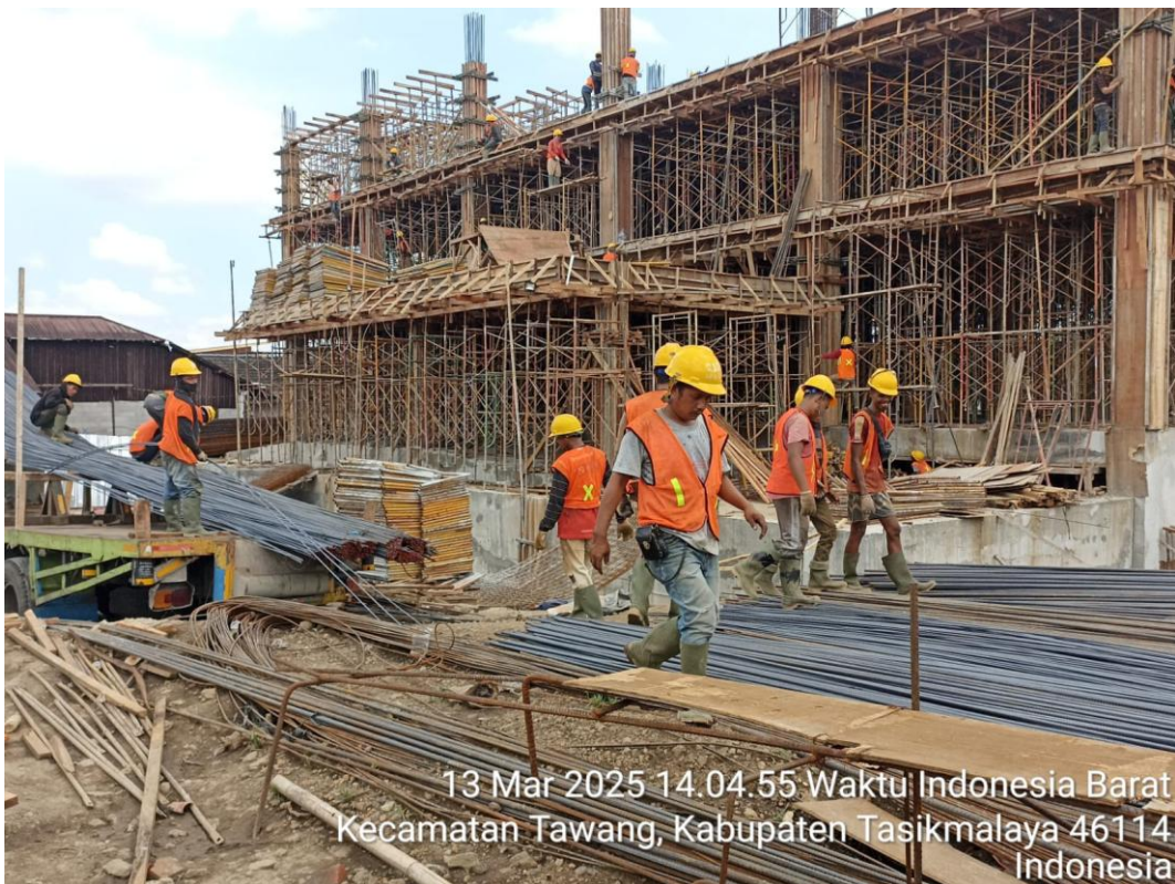
Gambar 3.24 Bekisting Kayu pada Gedung
