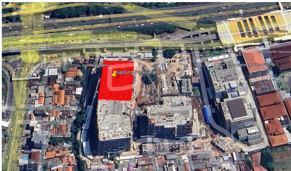
Gambar 3.1 Proyek Pembangunan Gedung Pelayanan Institut Neurosains Nasional (INN)
