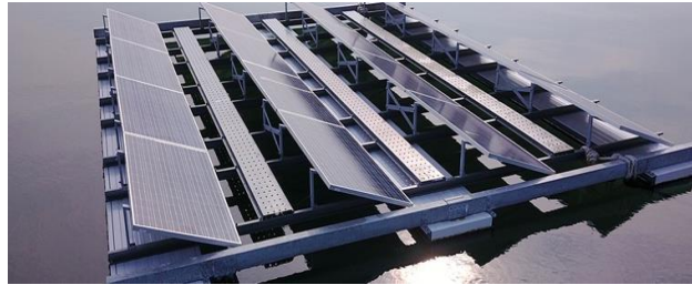
Gambar 2.14 Floater baja atau alumunium (ESDM, 2021).
