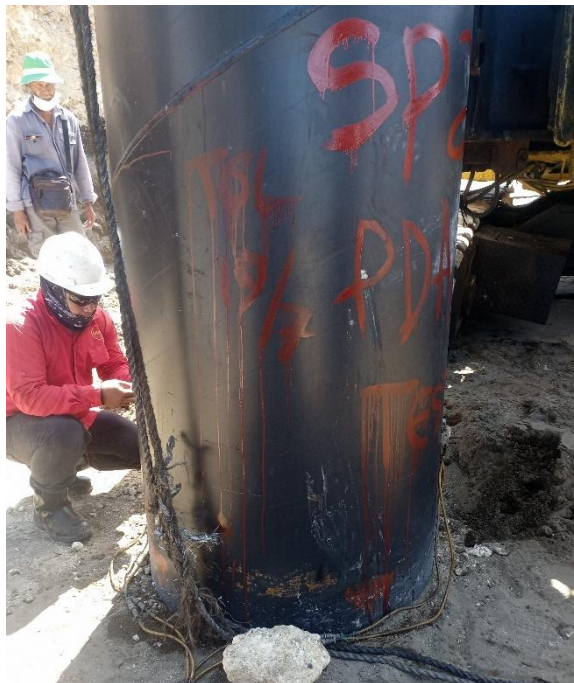
Gambar 4.3 Pemasangan alat uji PDA pada Tiang Pancang SP2.
