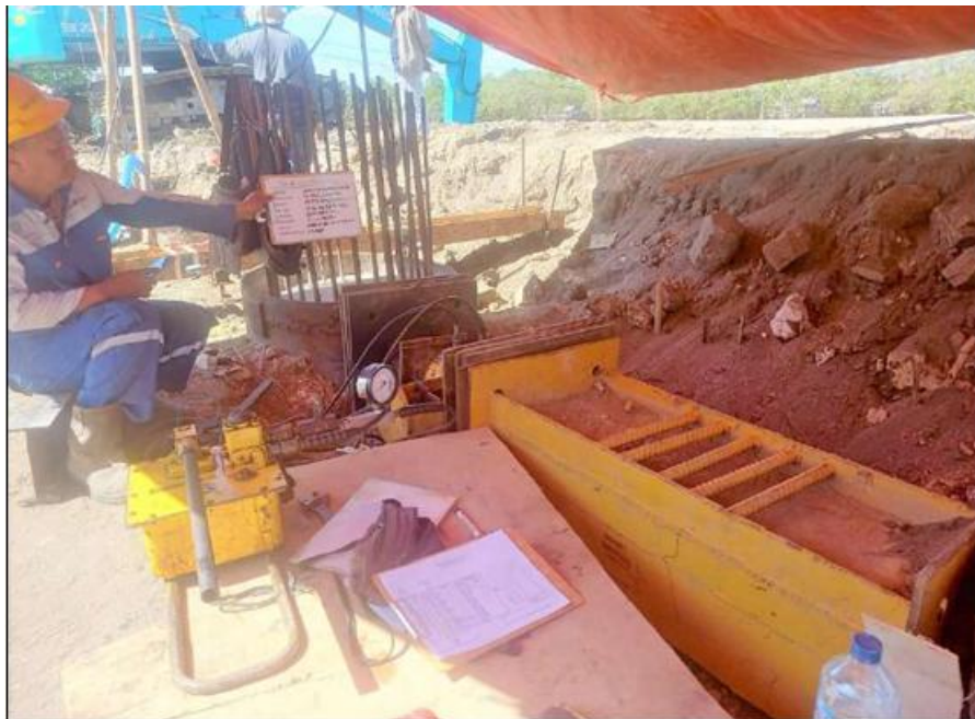
Gambar 4.16 Tiang Uji SP14 beserta alat-alat pengujian lateral.
