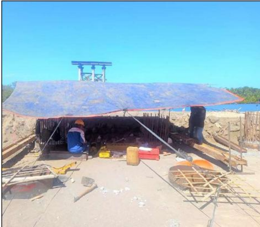
Gambar 4.15 Pengujian Lateral Tiang Pancang SP14 pada Abutment A1.
