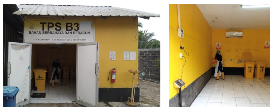
Gambar 4.15 Kondisi Fisik TPS B3, Belum Ada Ventilasi dan Pencahayaannya Bersumber dari Lampu
