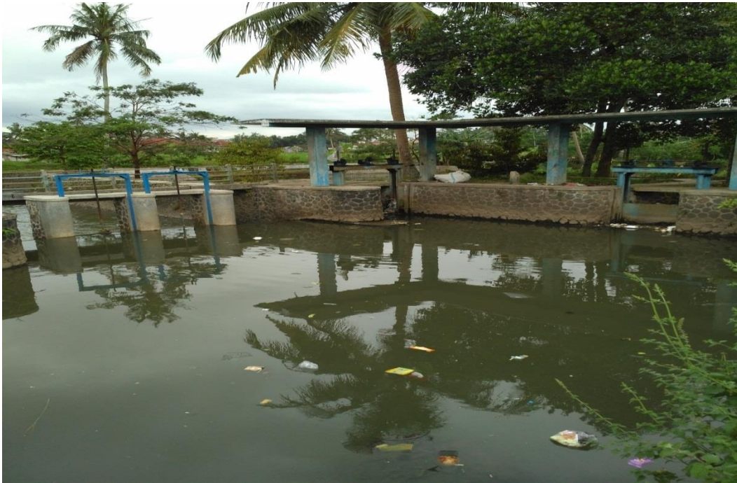
Gambar 3.3 bangunan pembagi cikalamunding
