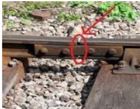
Gambar 2.2 Gambar Sambungan antar Rel Kereta Api
