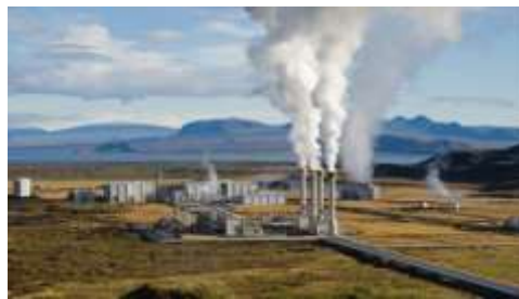
Gambar 2. 8 Pembangkit Listrik Tenaga Panas Bumi (PLTPB)
