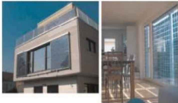
Gambar 2.5 Penerapan BIPV pada bangunan Ilustrasi Building Integrated Photovoltaics atau BIPV. (Foto: maysunsolar)
