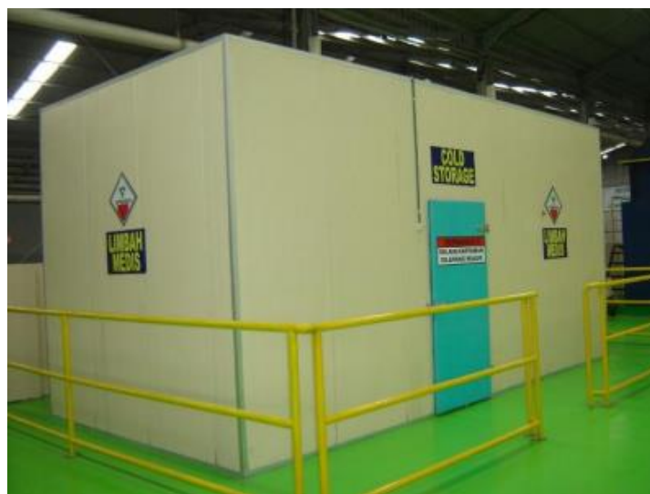
Gambar 2.12 Contoh Ruang Pendingin untuk Penyimpanan Limbah B3 seperti Limbah Infeksius, Benda Tajam, dan/atau Patologis (Kementerian LHK RI, 2015)
