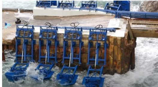
Gambar 2.5 Pembangkit Listrik Tenaga Gelombang Laut (Sumber : https://images.app.goo.gl/MNARNqoaDxhyk3i56 )
