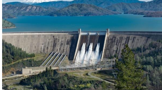
Gambar 2.4 Pembangkit Listrik Tenaga Air
