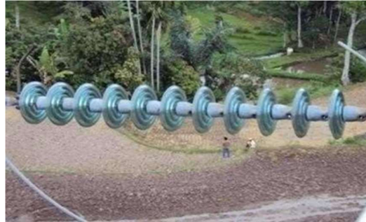
Gambar 2. 11 Isolator Gelas atau Kaca
