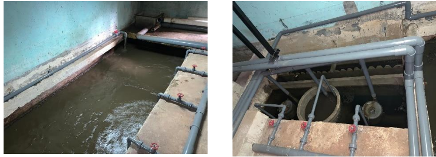
Gambar 4. 6 Proses Pengolahan Limbah Cair Di Rumah Sakit Prasetya Bunda
