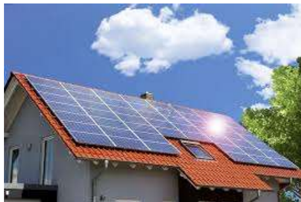
Gambar 2.9 Sel surya yang dapat menghasilkan energi listrik
