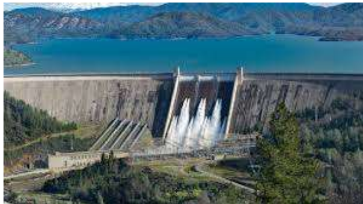
Gambar 2.12 Pemanfaatan Energi Air Pada Bendungan
