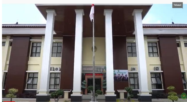
Gambar 2.1 Gedung Pengadilan Agama Kota Tasikmalaya
