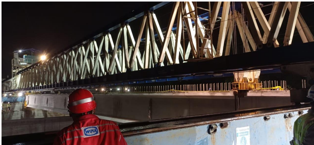
Gambar 2.16 Erection Girder Menggunakan Launcher Gantry.
