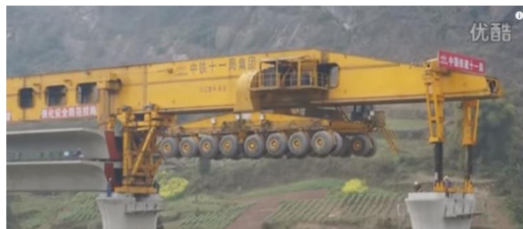
Gambar 2.19 Pekerjaan Erection Menggunakan Monster Mechine Drop Girder .
