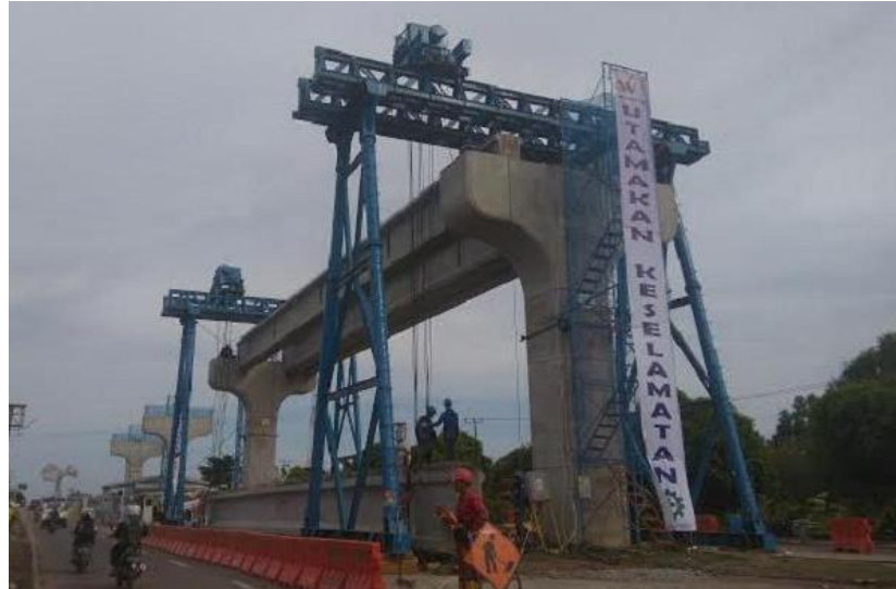
Gambar 2.17 Pekerjaan Erection menggunakan Portal Gantry .
