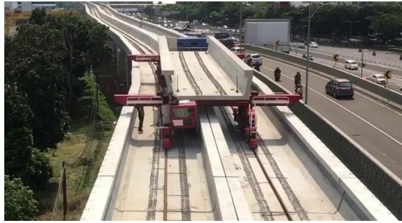
Gambar 2.18 Pekerjaan Erection menggunakan Gantry Kura-Kura.
