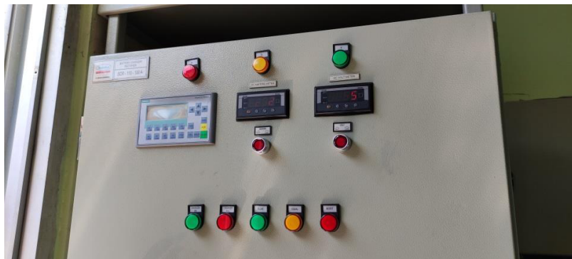
Gambar 3. 3 Rectifier(Charger)
