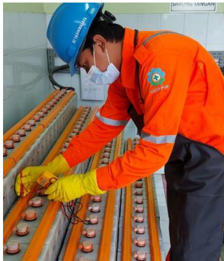
Gambar 3. 7 Proses pengukuran tegangan
