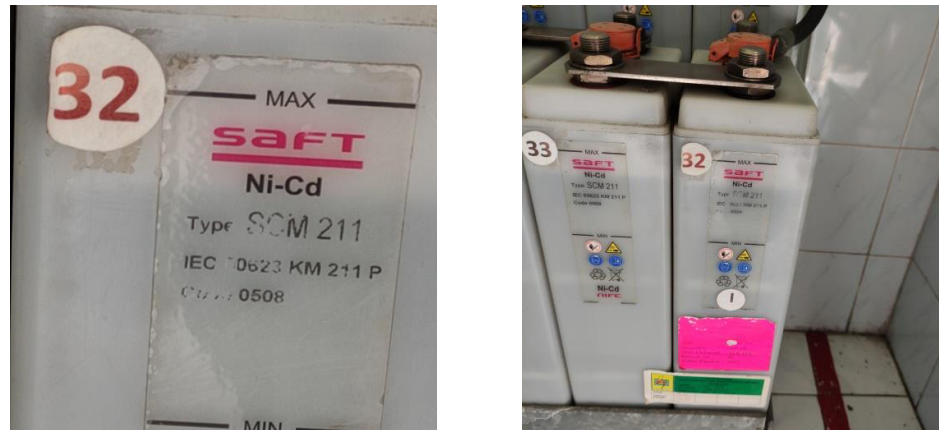
Gambar 2. 20 Baterai 110V
