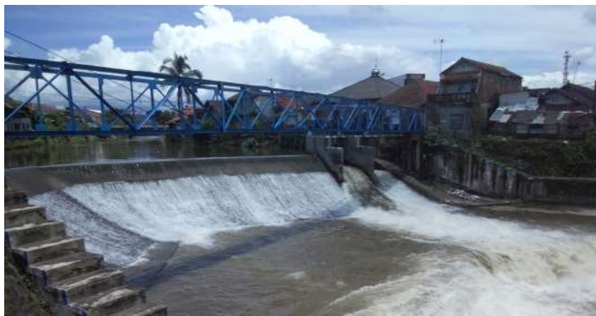
Gambar 3.3 Kondisi Bendung Cimulu
