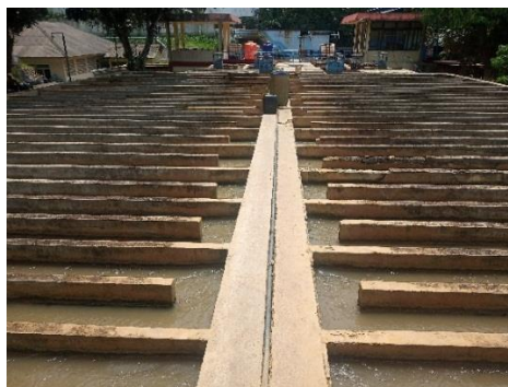
Gambar 2.11 Bak Flokulasi IPA Purwaharja PDAM Tirta Anom
