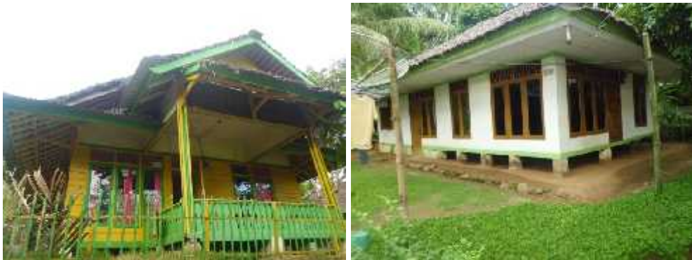
Gambar 5.25 Kondisi Rumah Yang Sesuai Aturan di Kampung Kuta
