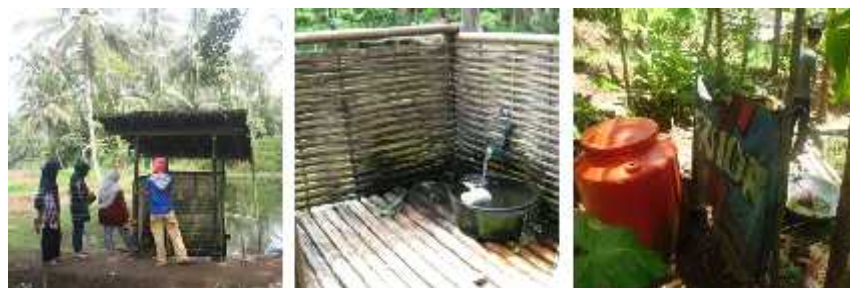
Gambar 5.53 Fasilitas Jamban Tanpa Sumur Gali
