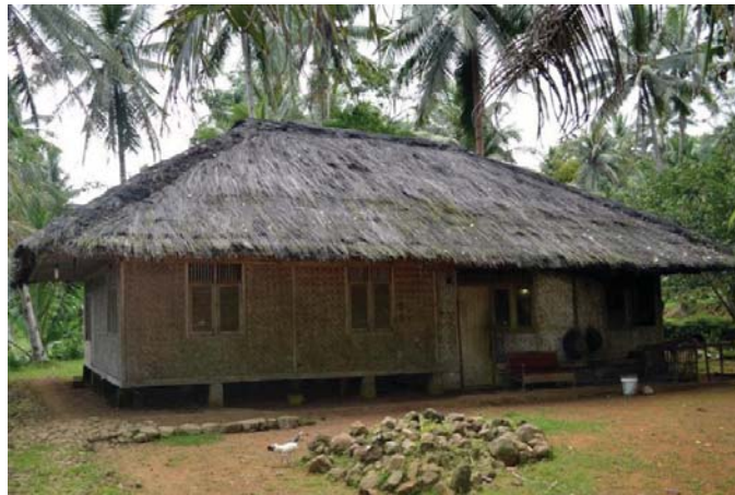
Gambar 6 :Kondisi Rumah di Kampung Kuta
