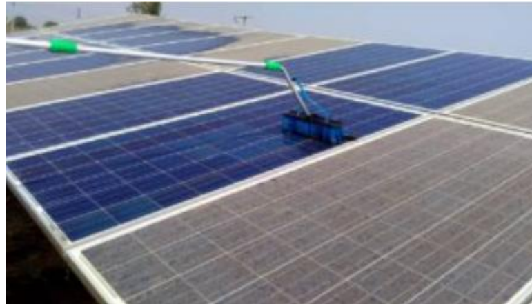
Gambar 2. 23 soiling pada permukaan panel surya (Mangatur, 2022)
