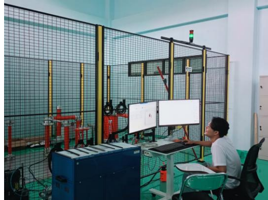
Pengoprasian Alat Tegangan Tinggi (TERCO)
