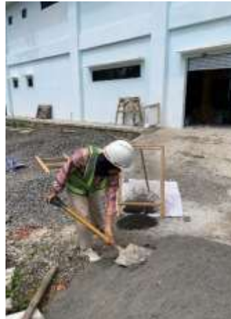
Penyaringan Agregat Halus
