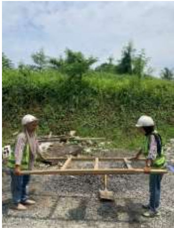
Penyaringan Agregat Kasar
