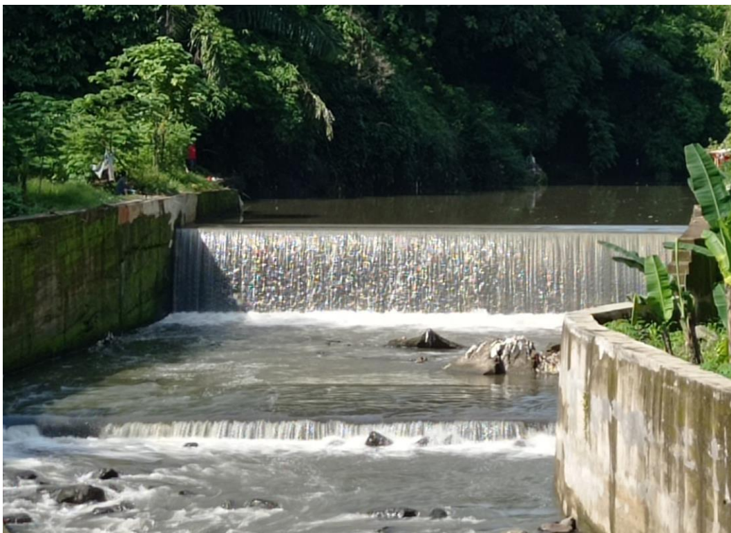
Gambar 3.1 Kondisi Eksisting Check Dam Margaluyu
