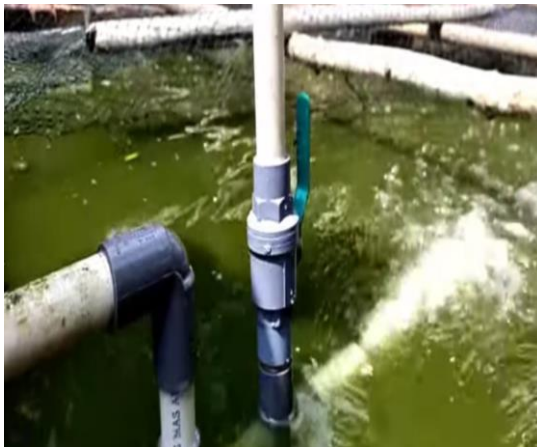
Pipa air dari Sungai Ciloseh
