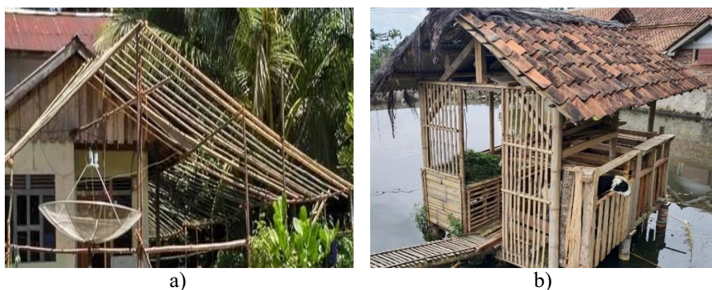
Gambar 2.11 Bambu sebagai konstruksi bangunan
