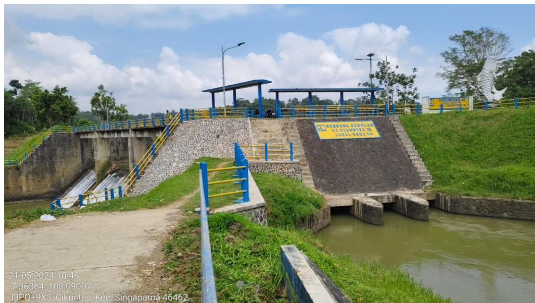
Gambar 3.2 Kondisi Bendung Ciwulan Sumber: Dokumentasi Lapangan, 2024.
