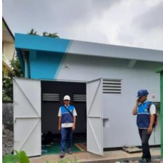
Gambar 2. 12 Gardu beton atau gardu kios
