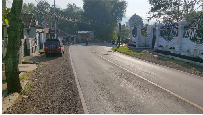
Gambar 3.2 Kondisi Tikungan Panyusunan Ruas Jalan Raya Ciawi (Sumber: Dokumentasi Pribadi)
