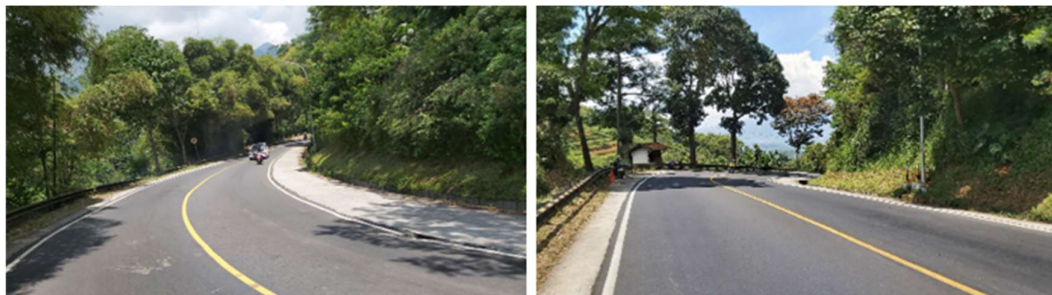
Gambar 3.4 Kondisi Tanjakan Puspa dan Tanjakan Strawberry Ruas Jalan Raya Kadipaten (Sumber: Dokumentasi Pribadi)
