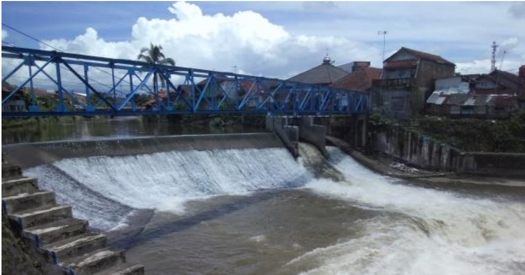
Gambar 3.2 Kondisi Bendung Cimulu
