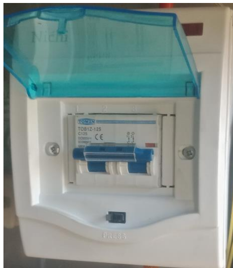
Gambar 2.17 MCB untuk Arus DC
