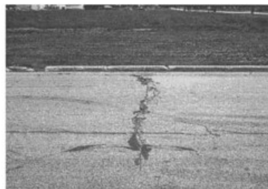
Gambar 3.11 Tingkat keparahan kerusakan retak memanjang dan melintang
