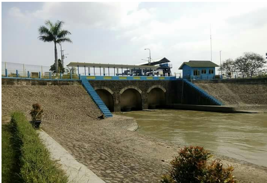
Gambar 3.3 Bendung Salamdarma Kabupaten Indramayu
