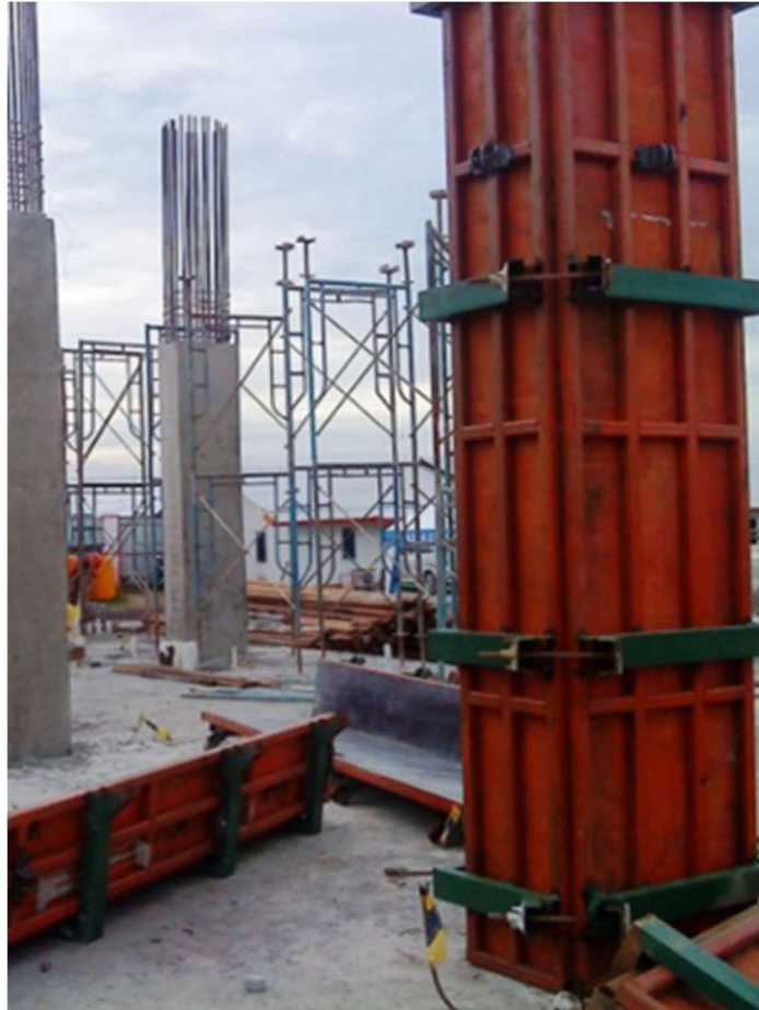
Gambar 2.2 Bekisting Semi sistem Proyek Pembangunan RSUD Ciawi.
