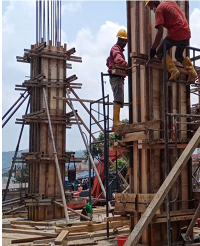
Gambar 2.1 Bekisting Konvensional Proyek RSUD Ciawi Kabupaten Bogor.
