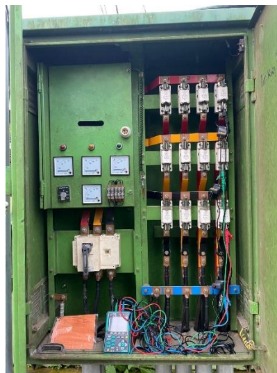
Gambar 3. 2 Proses Pengukuran Beban menggunakan Power Quality Analyzer Kyoritsu KEW6135
