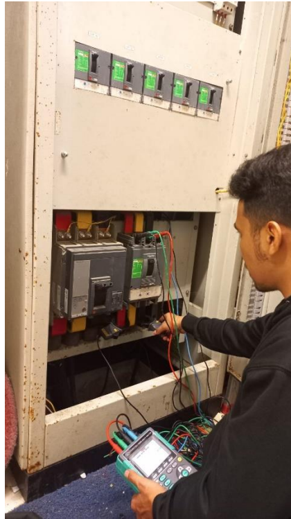
Gambar 3. 7 Pemasangan Alat Pada Panel
