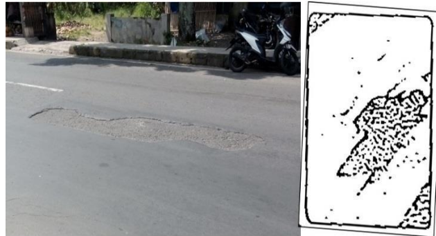
Gambar 2.24 Pengelupasan lapisan permukaan ( stripping )
