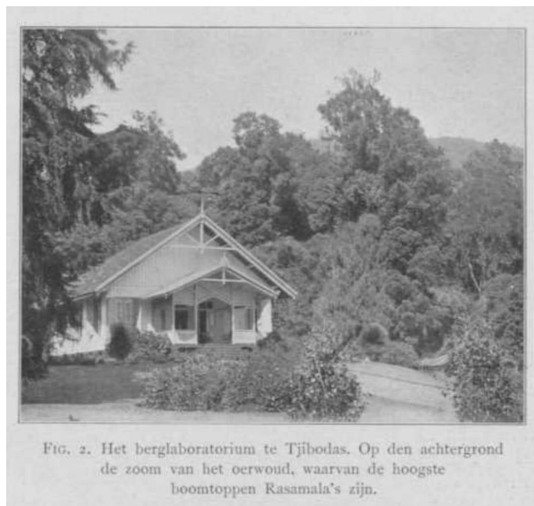
Gambar 3.3. Wisma Tamu dengan Laboratorium bagian luar. Sumber: 'S Land Plantentuin Te Buitenzorg 18 Mei 1817-18 Mei 1892 . (1892). Batavia: Lndsrukkerij
