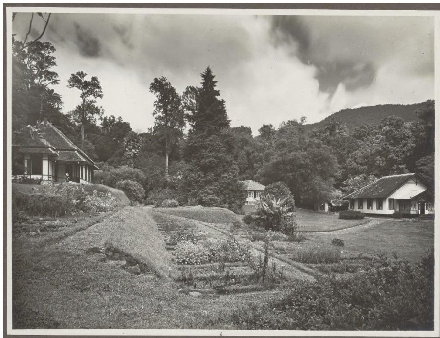
Gambar 3.9. kanan, wisma tamu dengan laboratorium, tengah, rumah pengawas, kiri, laboratorium baru. antara tahun 1920-1930. Sumber: https://www.collectienederland.nl
