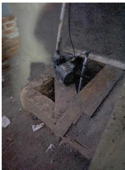
Gambar 4. 8 Sumur Pompa Listrik yang Digunakan Sebagai Sumber Air Bersih di Kelurahan Setiaratu
