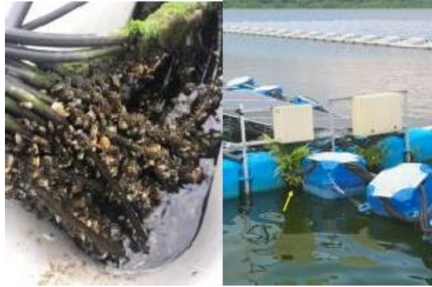
Gambar 2. 15 Biofouling pada kabel (ESDM, 2021)
