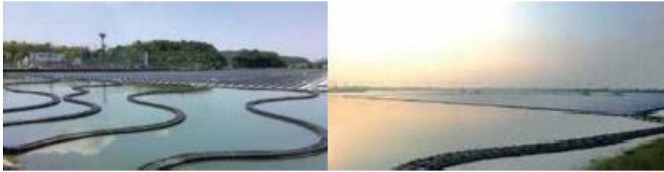
Gambar 2. 12 Rute kabel yang berbentuk S (ESDM, 2021)
